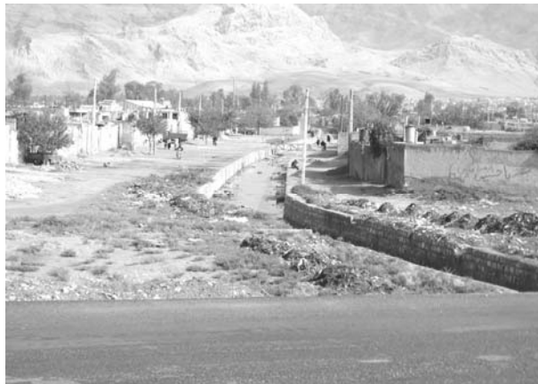
شکل ۷ کانالهای موجود در جنوب شهر به صورت کانال فاضلاب و تغییر کاربری داده و دارای شیب نامناسب می باشد.
