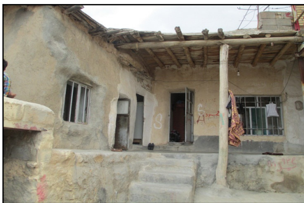
شکل ۵. استفاده از ایوان در روستاهای کهریزوروش و قلعه رستم از توابع شهرستان‌های نورآباد و ازنا مشخصات فضاهای بهداشتی (حمام و دستشویی)
