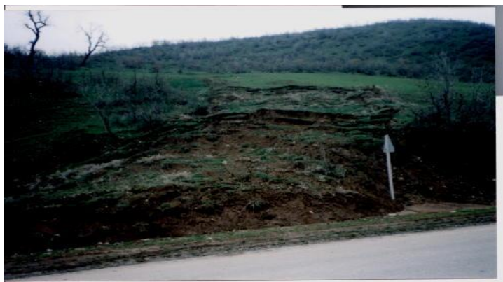
محور) شیخ پیر در لغزش زمین به منجر دامنه پای در جاده احداث و زراعی زمین به جنگل از زمین کاربری تغییر: (5) عکس است شده (سردشت-پیرانشهر)
