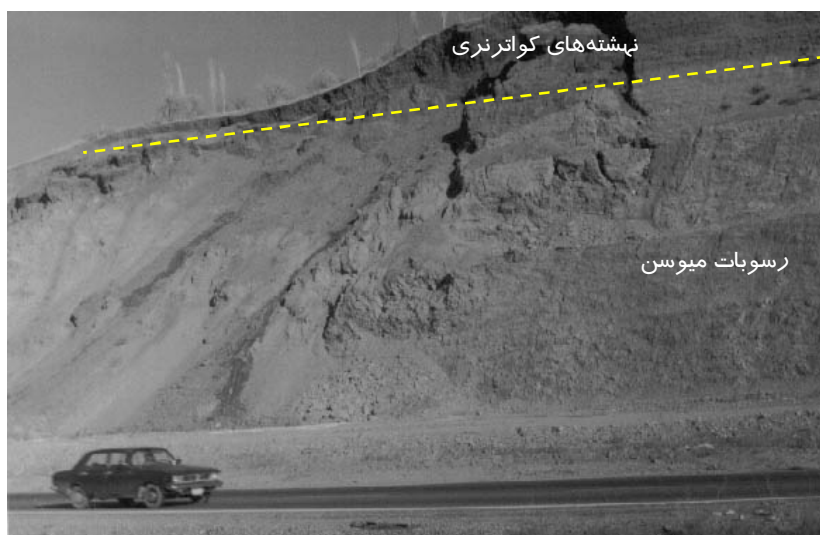
شکل 4 ناپایداریهای حاصل از ایجاد ترانشه برای احداث باند جدید راه صوفیان- مرند
