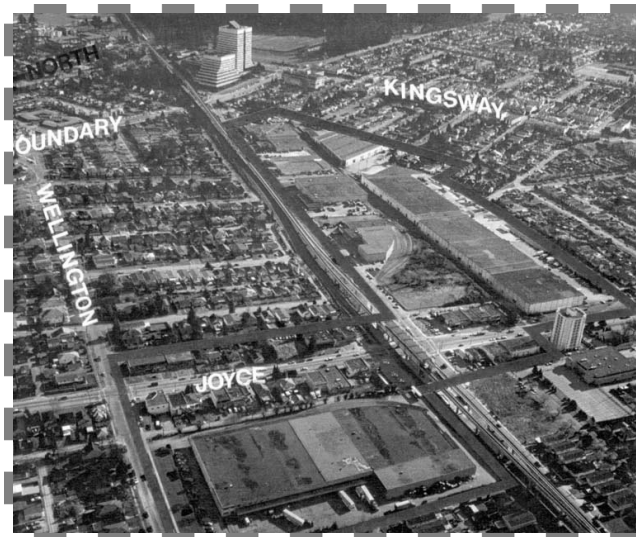
شکل ۲ ونکور قبل از اجرای طرح TOD
