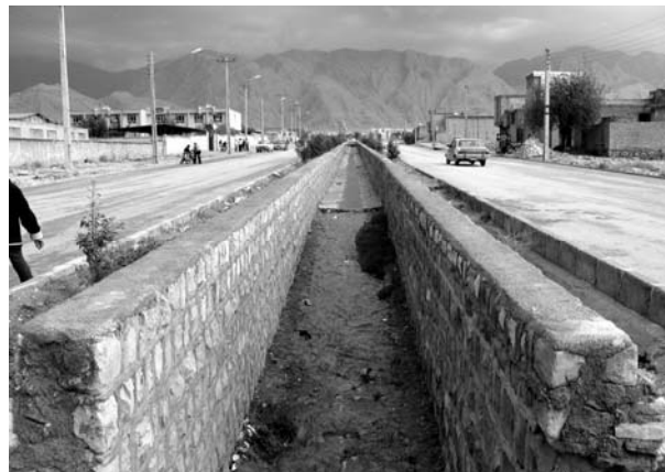
شکل ۸ کانالهای موجود شمال شهر دارای شیب مناسب
