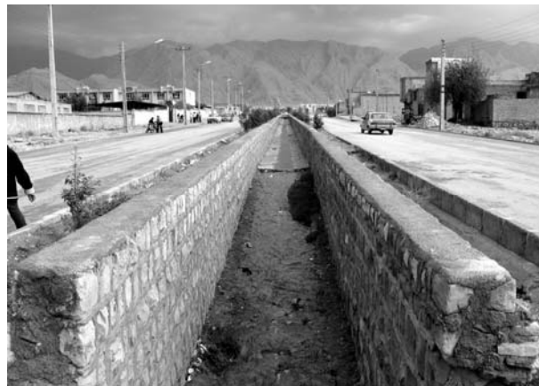
شکل ۸ کانالهای موجود شمال شهر دارای شیب مناسب
