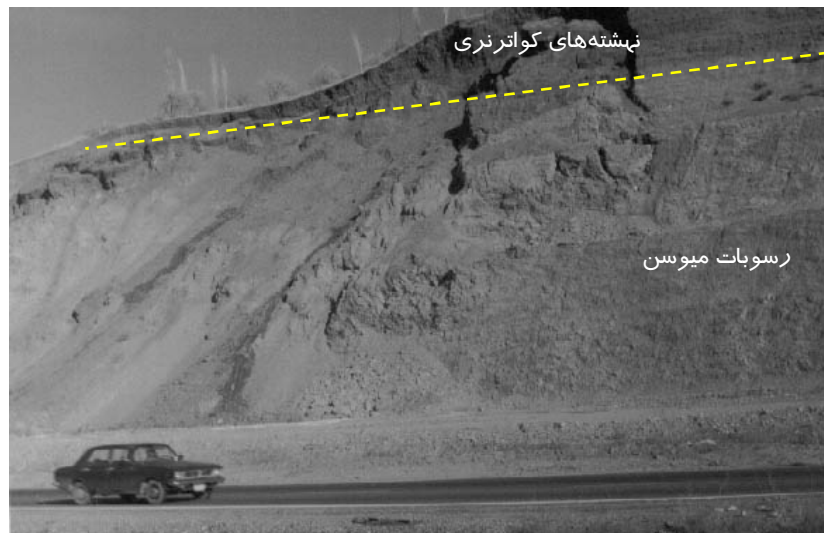
شکل 4 ناپایداریهای حاصل از ایجاد ترانشه برای احداث باند جدید راه صوفیان- مرند
