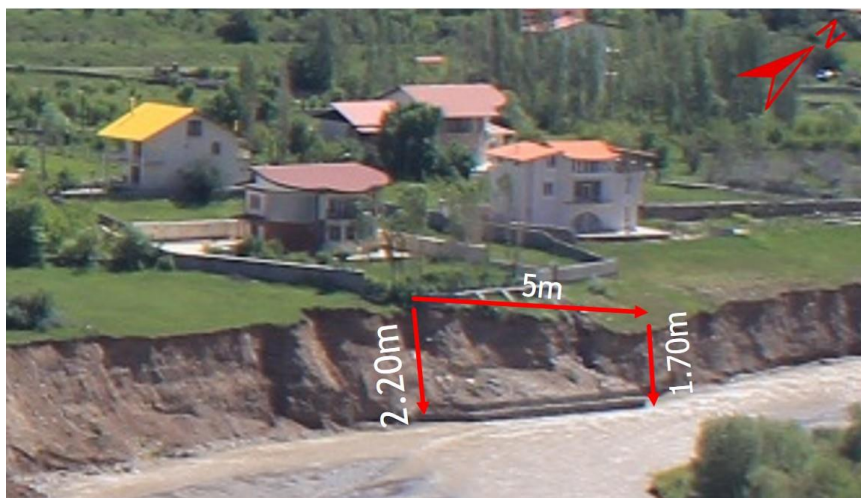
عکس ۱ دیوارکشی برای کنترل و مهار گسترش پیچان‌رود روستای جزن
