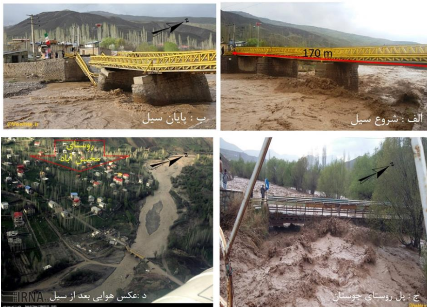
عکس ۳ تخریب پل‌های روستای (الف، ب، ج، پل وشته)، (ج، پل جوستان) در نتیجه تغییر سطح اساس شاه‌رود بعد از احداث سد در سیل فروردین ۱۳۹۴
