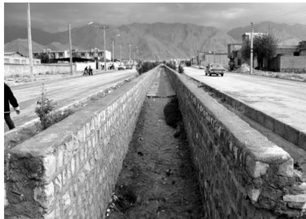
شکل ۸ کانالهای موجود شمال شهر دارای شیب مناسب
