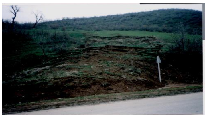
محور) شیخ پیر در لغزش زمین به منجر دامنه پای در جاده احداث و زراعی زمین به جنگل از زمین کاربری تغییر: (5) عکس است شده (سردشت-پیرانشهر)
