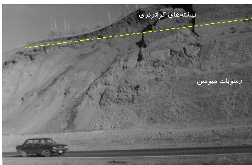
شکل 4 ناپایداریهای حاصل از ایجاد ترانشه برای احداث باند جدید راه صوفیان- مرند
