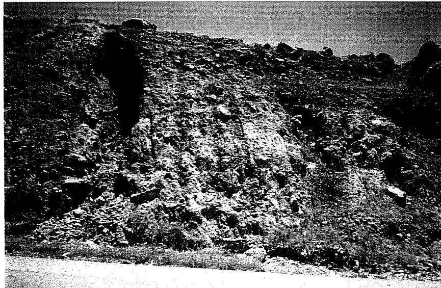
شکل ۱۲ حفره‌های ریزشی ناشی از نفوذ آبهای سطحی به درون رسوبات دریاچه‌ای سیمره و انحلال مواد قابل حمل از درون آنها زمان و محل عکسبرداری: شمال روستای هلوش، کنار جاده سراب جهانگیر به دره شهر (خردادماه ۱۳۸۲)
